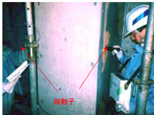
写真 4.7 柱を挟み込んだ測定状況
