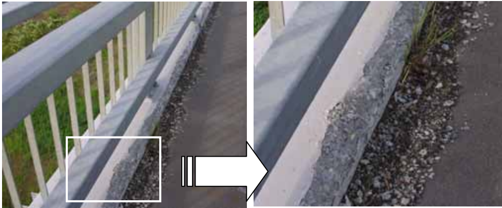
写真 3.6 地覆表面を凍害補修しているが、スケーリング再劣化している状態
