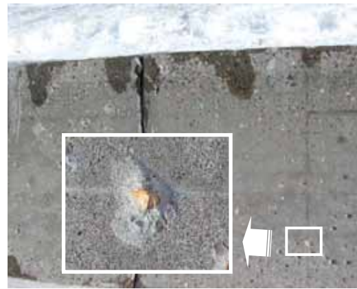
写真 3.18 海岸擁壁表面のポップアウト
