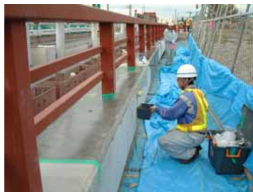
写真 6.1 表面改質材施工状況
