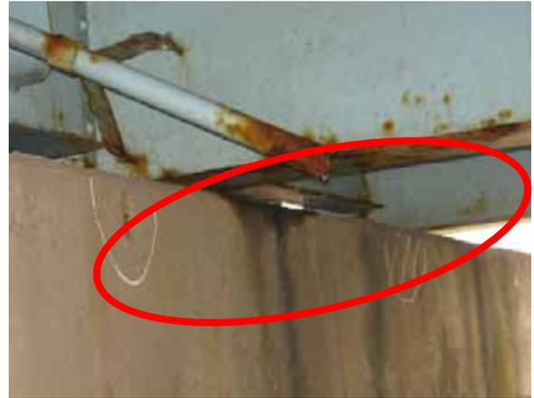
凍結防止剤による鋼橋塗膜劣化
