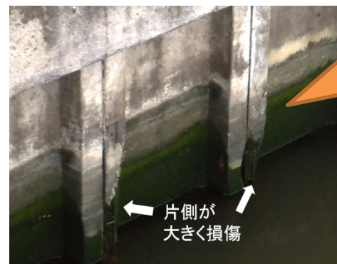
河川構造物の劣化損傷状況
