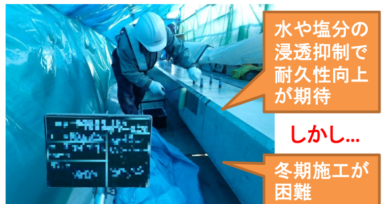
冬期の防寒仮囲い内での施工状況
