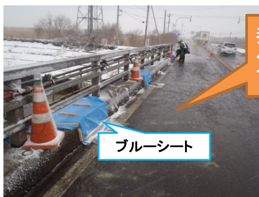
耐寒促進剤を使用したコンクリートの養生状況
