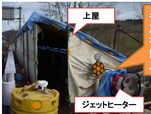
寒中コンクリートの養生状況
