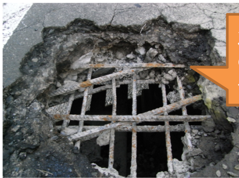
既設RC床版の劣化損傷状況
