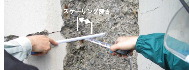
スケーリング深さの測定状況
