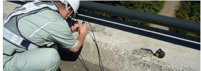
写真-1 点検状況(道路橋) 測定点数は8点/箇所
