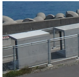
シラン系表面含浸材 ・塩分浸透の低減効果を確認
