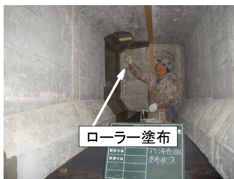
図-3 表面含浸材の施工状況 （施工が冬期のため防寒養生を実施）
