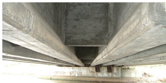
図-1 試験施工主桁（ポステンPC桁）の外観
