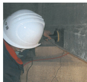
図-4 腐食速度の測定状況
