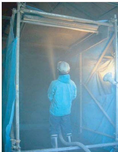
解説 写真-4.1 吹付け施工試験およびコンクリートの付着状況
