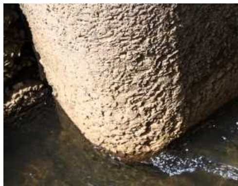
写真 ゲート（凍害劣化の外観評点 4）
