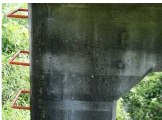
写真 門柱（凍害劣化の外観評点 2）
