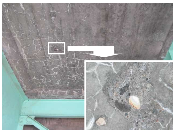
写真 3.17 鋼橋 RC 床版下面のポップアウト
