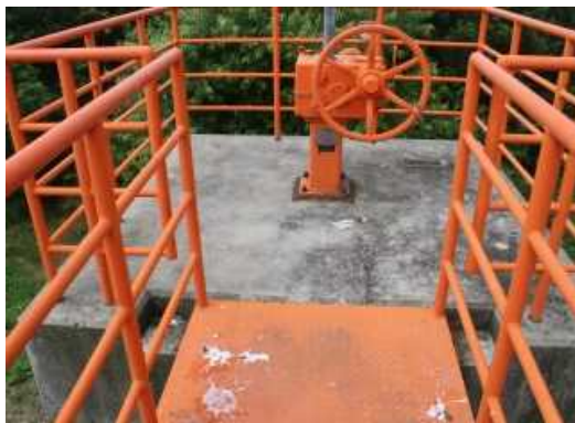
写真 操作台（凍害劣化の外観評点 1）
