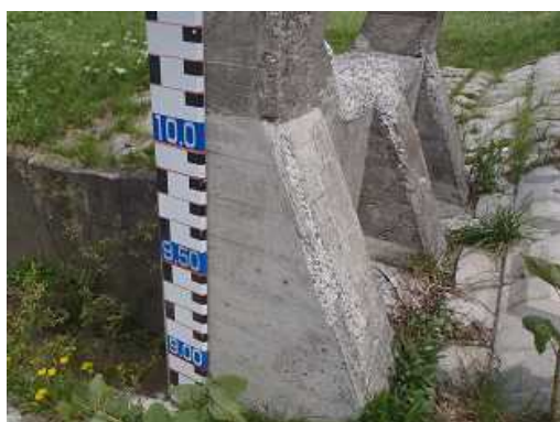
写真 門柱（凍害劣化の外観評点 5）
