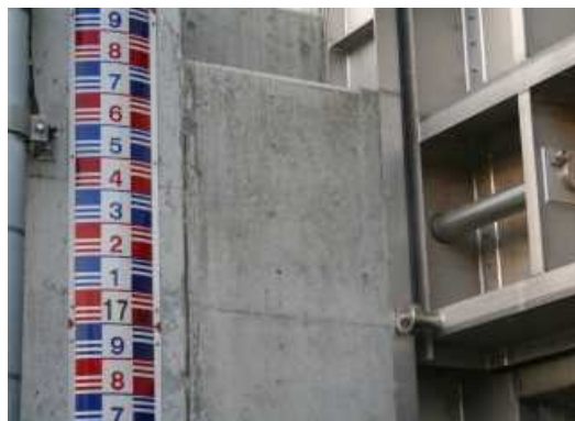
写真 ゲート（凍害劣化の外観評点 1）
