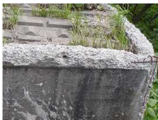
写真 擁壁（凍害劣化の外観評点 5）
