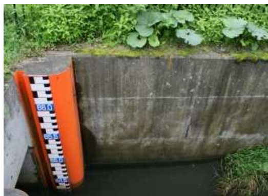
写真 擁壁（凍害劣化の外観評点 2）
