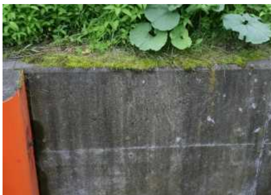
写真 擁壁（凍害劣化の外観評点 2）
