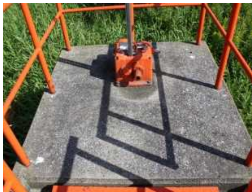
写真 操作台（凍害劣化の外観評点 3）
