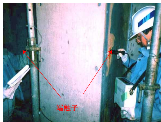
写真 4.7 柱を挟み込んだ測定状況
