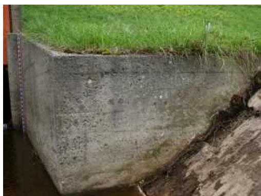
写真 擁壁（凍害劣化の外観評点 3）
