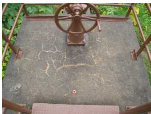
写真 操作台上面の ASR によるひび割れ
