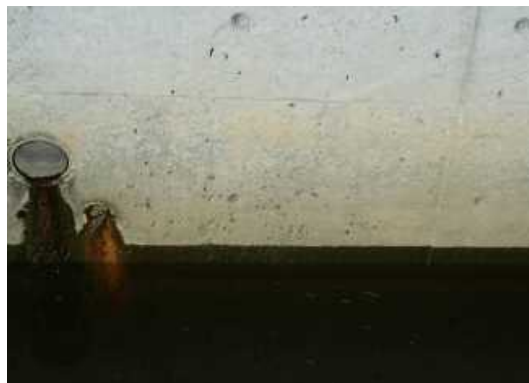
写真 擁壁（凍害劣化の外観評点 1）
