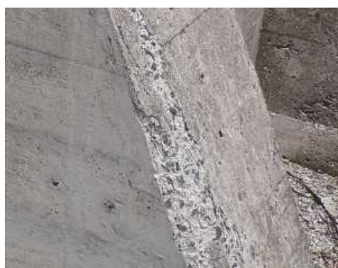
写真 門柱（凍害劣化の外観評点 4）
