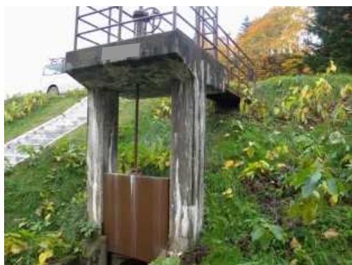
写真 操作台下面の ASR によるひび割れ
