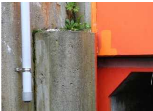
写真 ゲート（凍害劣化の外観評点 2）
