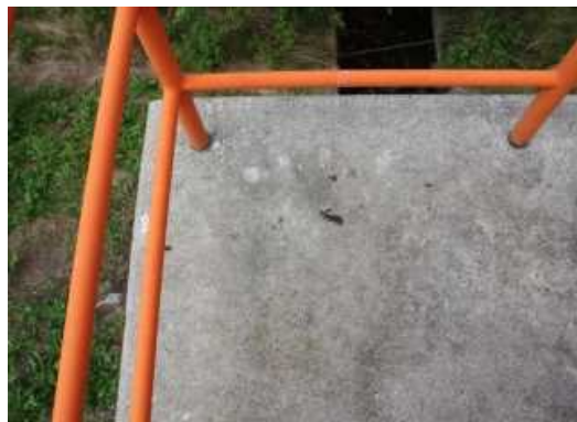
写真 操作台（凍害劣化の外観評点 1）
