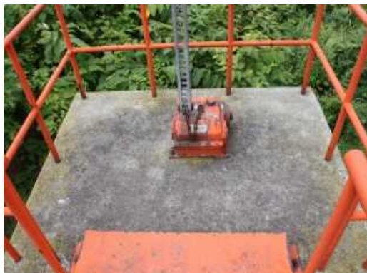
写真 操作台（凍害劣化の外観評点 2）
