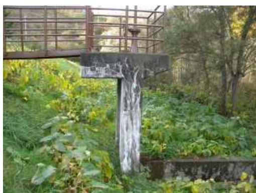
写真 操作台側面の ASR によるひび割れ
