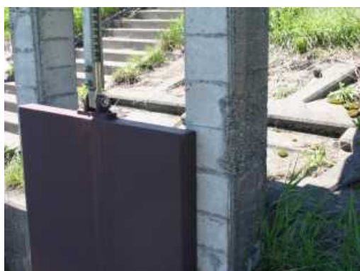
写真 門柱（凍害劣化の外観評点 3）
