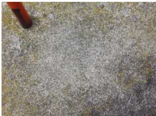
写真 操作台（凍害劣化の外観評点 2）
