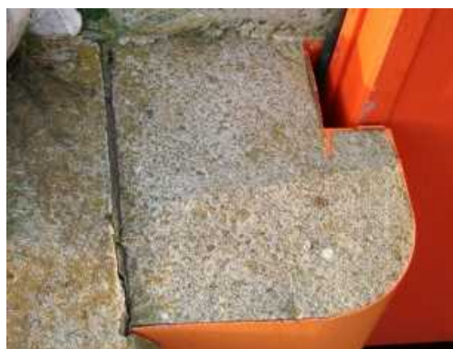
写真 ゲート（凍害劣化の外観評点 3）
