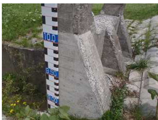
写真 門柱（凍害劣化の外観評点 4）
