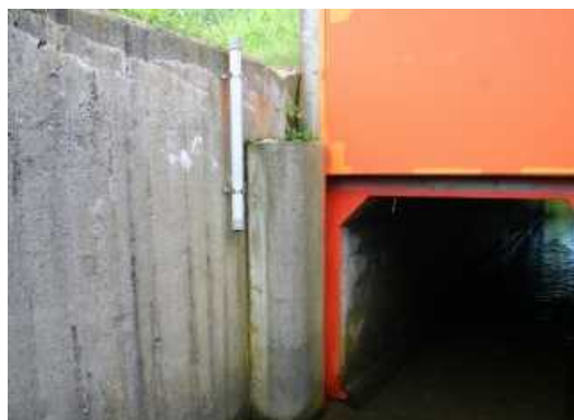
写真 ゲート（凍害劣化の外観評点 2）
