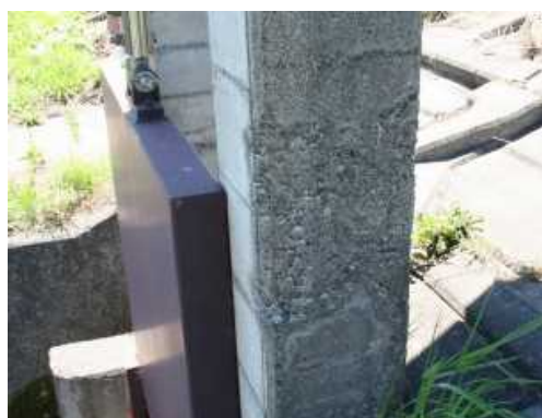
写真 門柱（凍害劣化の外観評点 3）
