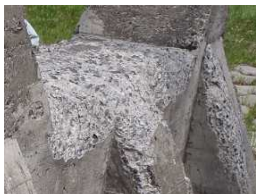
写真 門柱（凍害劣化の外観評点 5）
