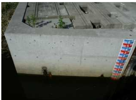
写真 擁壁（凍害劣化の外観評点 1）
