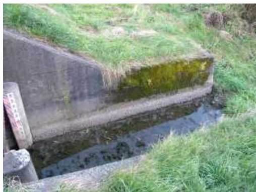
写真 擁壁（凍害劣化の外観評点 4）
