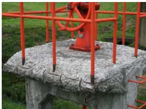
写真 操作台（凍害劣化の外観評点 5）
