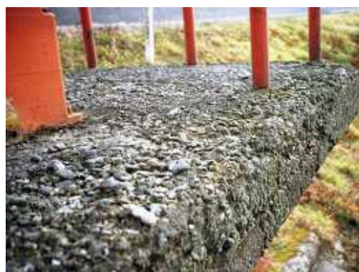
写真 操作台（凍害劣化の外観評点 5）
