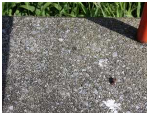
写真 操作台（凍害劣化の外観評点 3）
