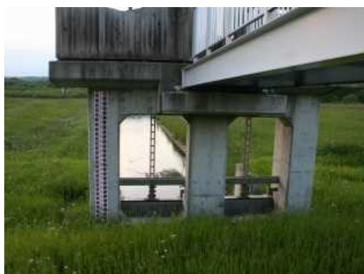
写真 門柱（凍害劣化の外観評点 1）
