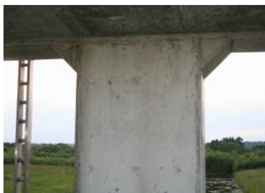
写真 門柱（凍害劣化の外観評点 1）
