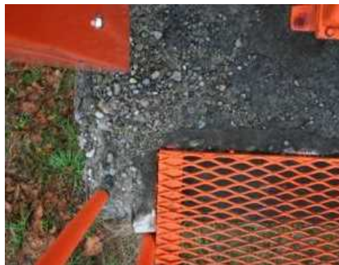
写真 操作台（凍害劣化の外観評点 4）
