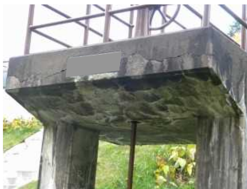
写真 操作台下面の ASR によるひび割れ
