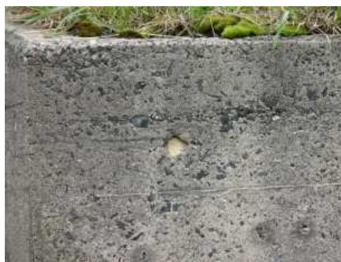
写真 擁壁（凍害劣化の外観評点 3）
