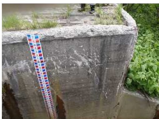
写真 擁壁（凍害劣化の外観評点 5）
