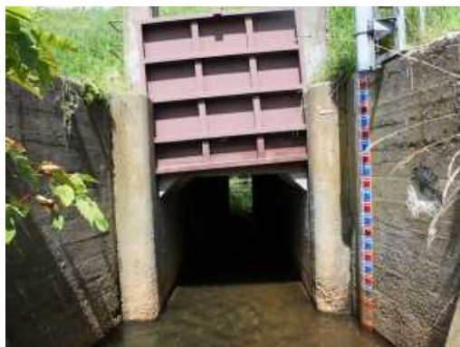
写真 ゲート（凍害劣化の外観評点 4）
