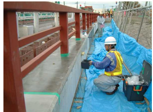
写真 6.1 シラン系表面含浸材施工状況
