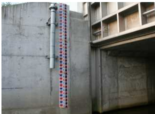
写真 ゲート（凍害劣化の外観評点 1）
