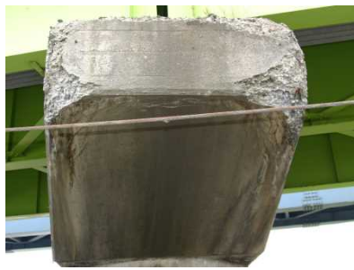
写真 1.2 ひび割れ部が はく離し骨材が露出 (加速期の例)
