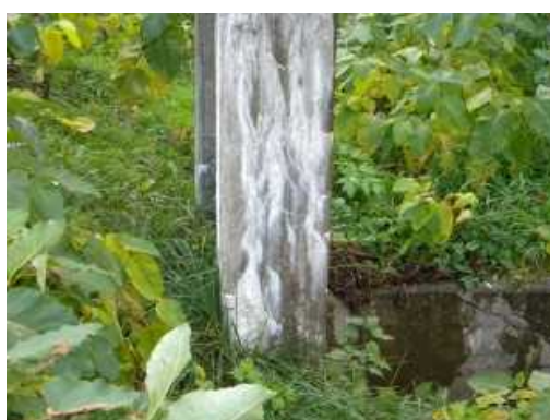
写真 門柱の ASR によるひび割れ
