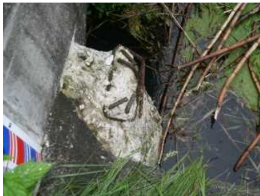
写真 ゲート（凍害劣化の外観評点 5）
