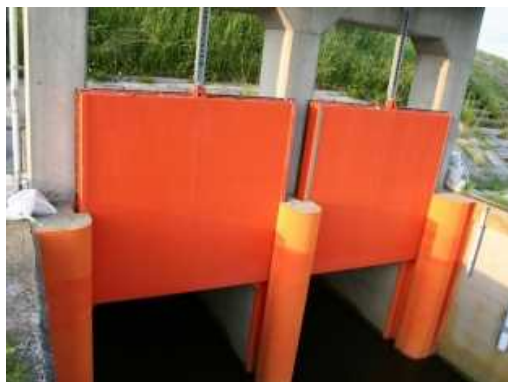
写真 ゲート（凍害劣化の外観評点 3）
