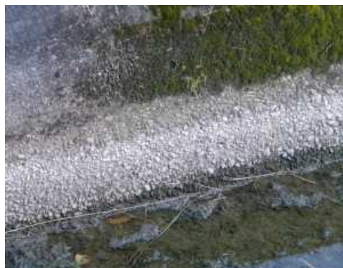
写真 擁壁（凍害劣化の外観評点 4）
