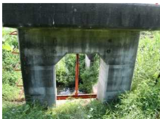
写真 門柱（凍害劣化の外観評点 2）
