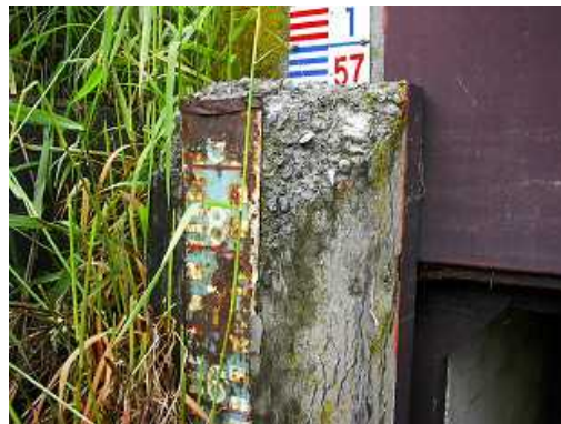
写真 ゲート（凍害劣化の外観評点 5）
