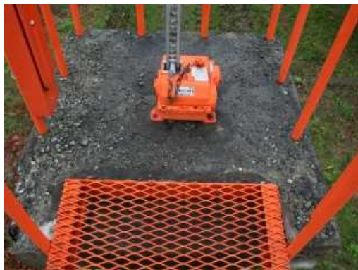
写真 操作台（凍害劣化の外観評点 4）
