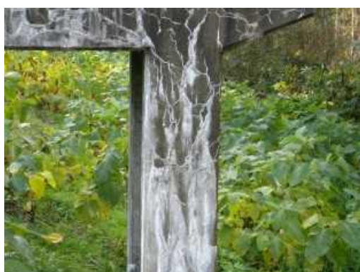
写真 門柱の ASR によるひび割れ
