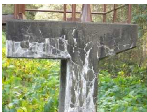
写真 操作台側面の ASR によるひび割れ
