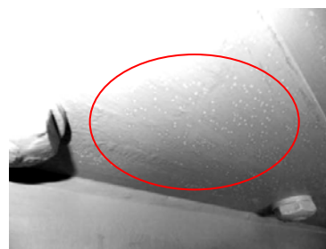
写真-11 上フランジの結氷状況
