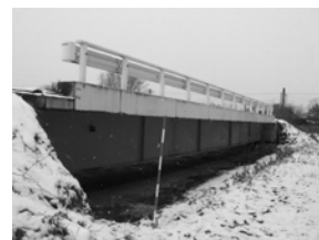
写真-4 模擬橋梁
