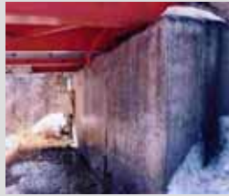
現地構造物劣化度調査
